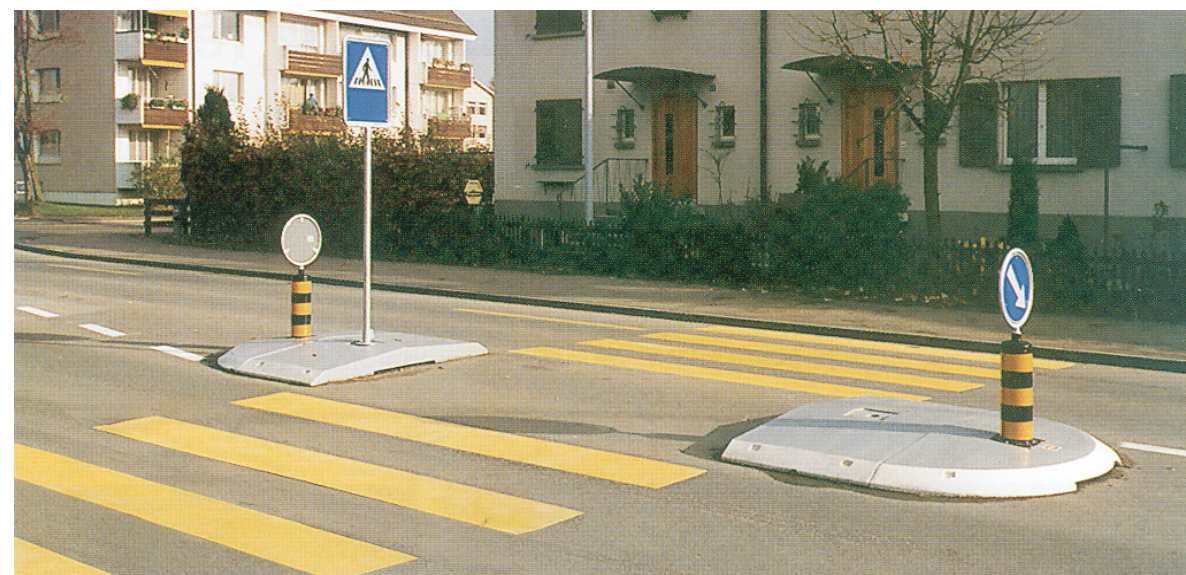
Un esempio di isolotto salvapedone prefabbricato per interventi rapidi di messa in sicurezza
