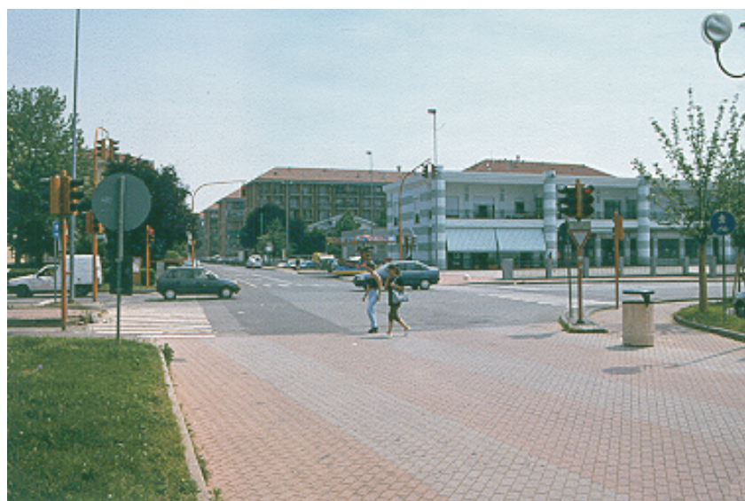
Attraversamento facilitato sui passaggi rialzati
