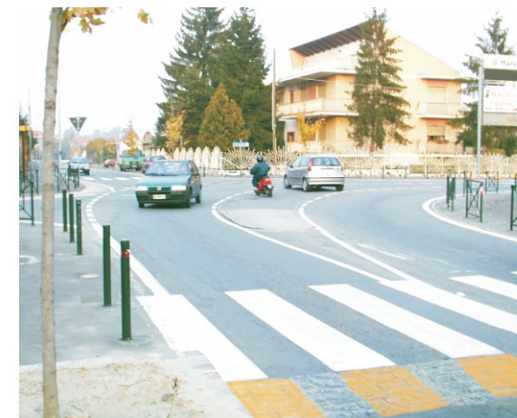
Rivalta (To): una zona di accumulo in curva (a "banana", foto sopra e progetto) protegge una via residenziale (foto sotto)
