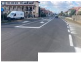
Viabilità e trasporti Nuova segnaletica stradale in Via Magistrini a Momo
