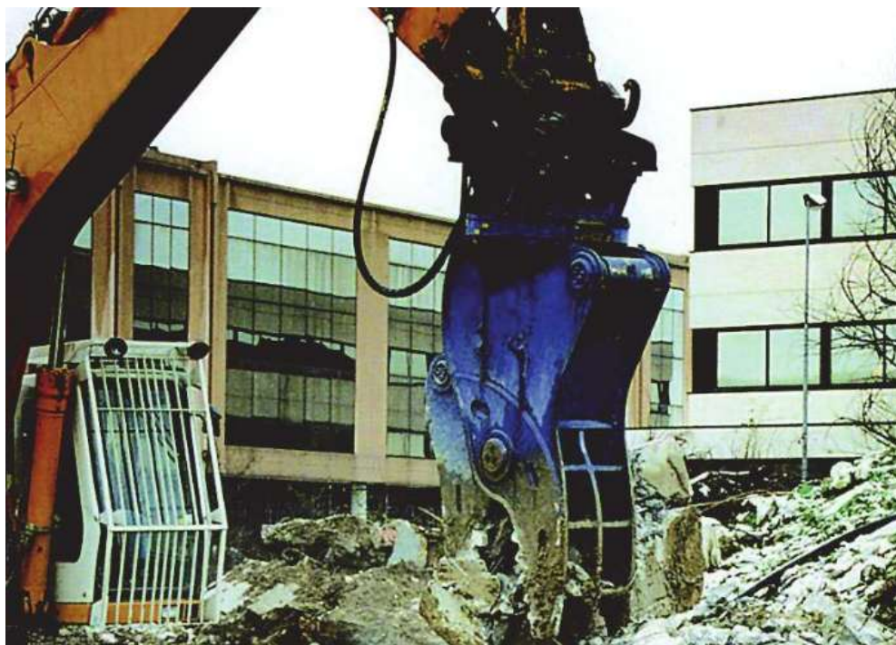
FOTO DI UN ESCAVATORE CON PINZA DEMOLITRICE
