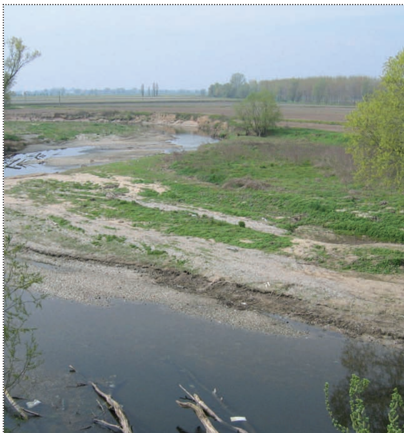
Figura 22. Esempio di scarpata in erosione.
