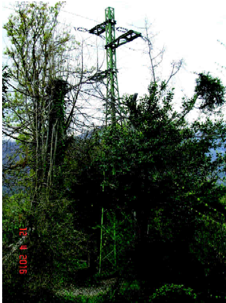
Fotografia n°11: tratto aereo della linea elettrica in area boscata - punto di connessione alla rete MT di Enel Distribuzione
