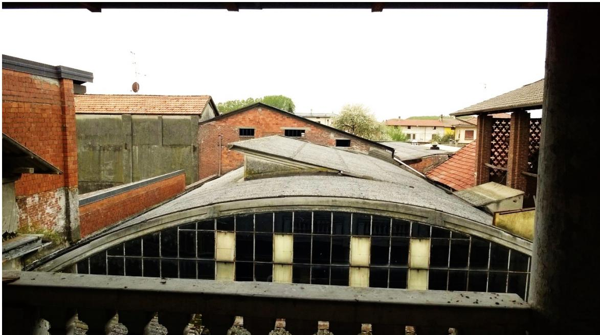
Vista della copertura in cemento amianto da rimuovere e sostituire
