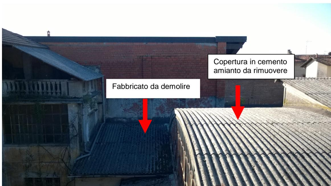
Vista della copertura in cemento amianto e del fabbricato da demolire
