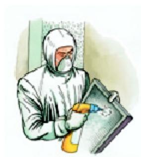
Prima di tagliare un tubo ricoperto con isolanti di amianto è necessario incapsularlo e proteggerlo adeguatamente con fogli di polietilene. Rimuovere preliminarmente nella zona di taglio, l'amianto con la tecnica di glovebags. Prima della rimozione: proteggersi con D.P.I. adeguati. Inumidire ed incapsulare gli elementi contenenti o contaminanti con amianto.
