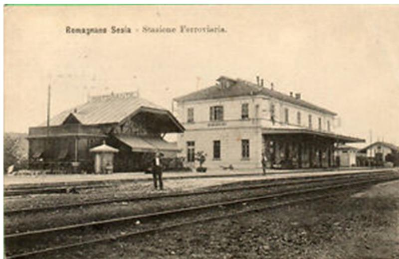
Durante la costruzione della ferrovia Santhià-Arona, attivata fra il 1905 e il 1906, si rese necessario alzare il piano del ferro in virtù del fatto che la nuova linea correva in rilevato per accedere al ponte sul fiume omonimo e così venne costruito un nuovo fabbricato viaggiatori, pochi metri più a sud rispetto all'originario, più grande.
